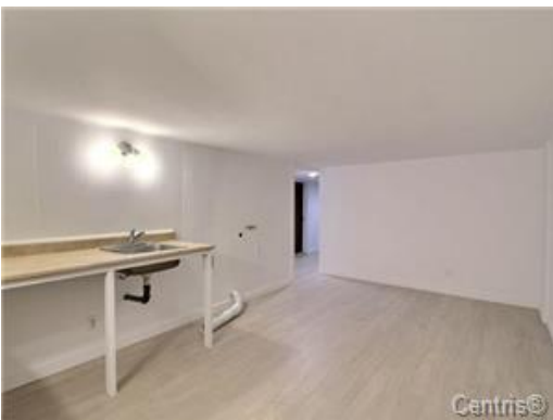
Salle de lavage
